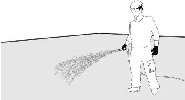
Substrat gut durchfeuchten und leicht auflockern. Startdüngung mit ca. 50 g/m<sup>2</sup> Langzeitdünger Opticote aufbringen.
