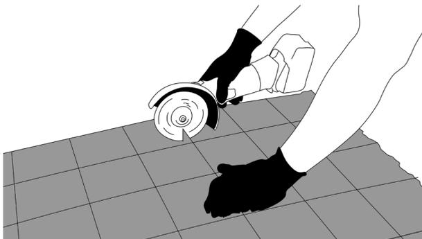
Dränelemente bei Bedarf mit Hilfe eines Winkelschleifers zuschneiden.
