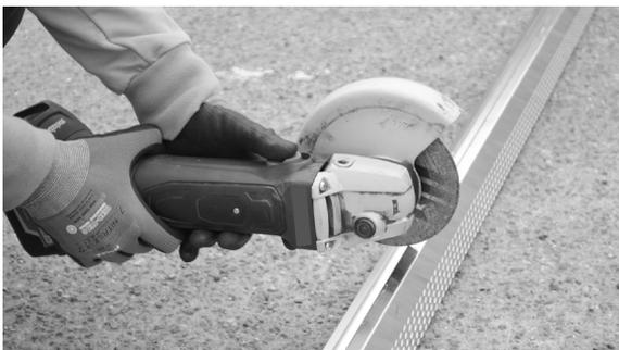
Zuschnitt und Bearbeitung der Kiesleisten mit Blechschere, Metallbügelsäge oder Winkelschleifer vornehmen.
