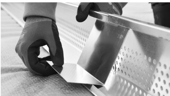
Einzelne Kiesleisten durch Verbinder längs gestoßen verbinden.
