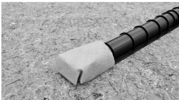
Die Stränge am Hochpunkt mit Filtervlies verschließen
