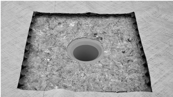
Die Ausschnitte in Schutzlage, Filtervlies und Dränelement müssen einen ungehinderten Abfluss des Überschusswassers zulassen.
