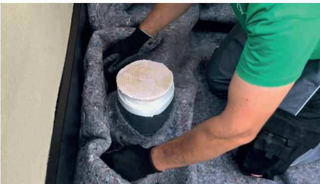
Abbildung 3: Verlegen der Schutzlage an aufgehenden Bauteilen
