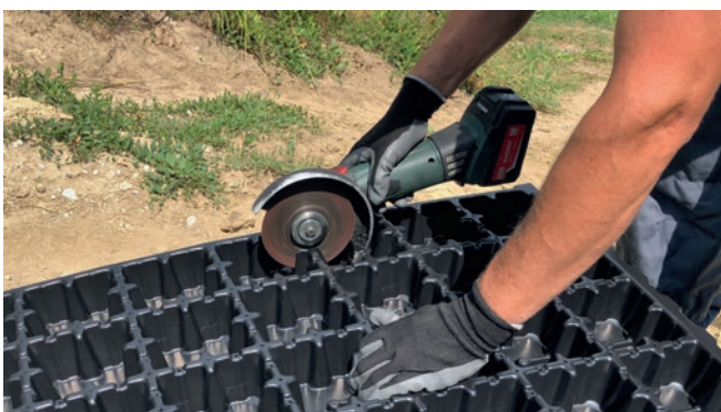
Abbildung 9: Zuschnitt des Dränelementes
