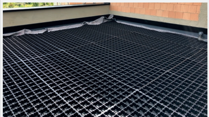
Abbildung 14: Unverfüllte Verlegung des Dränelementes FKD 6oBO
