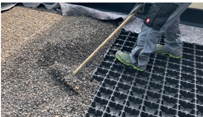
Abbildung 13: Verfüllung mit Dränschüttgut
