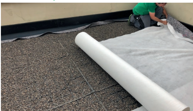
Abbildung 15: Verlegung von Filtervlies
