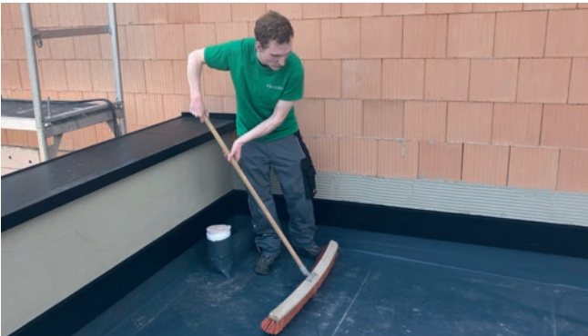
Abbildung 1: Säubern der Dachfläche
