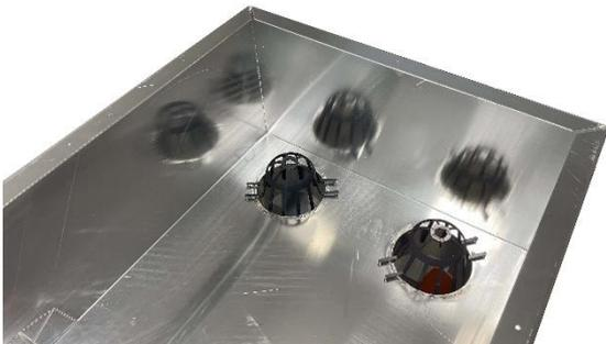
Abbildung 7: Laubfangkörbe einsetzen
