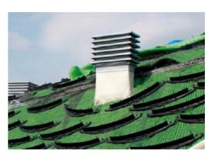
Größere Netzausschnitte erfordern eine Überbrückung mittels Klemmschienen über und unter den Ausschnitten. Max. Ausschnittsbreite 2,50 m
