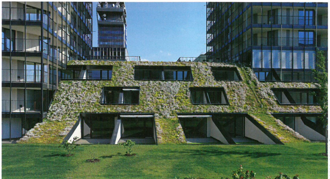
Die Außenanlagen gehen harmonisch in das begrünte Steildach über
