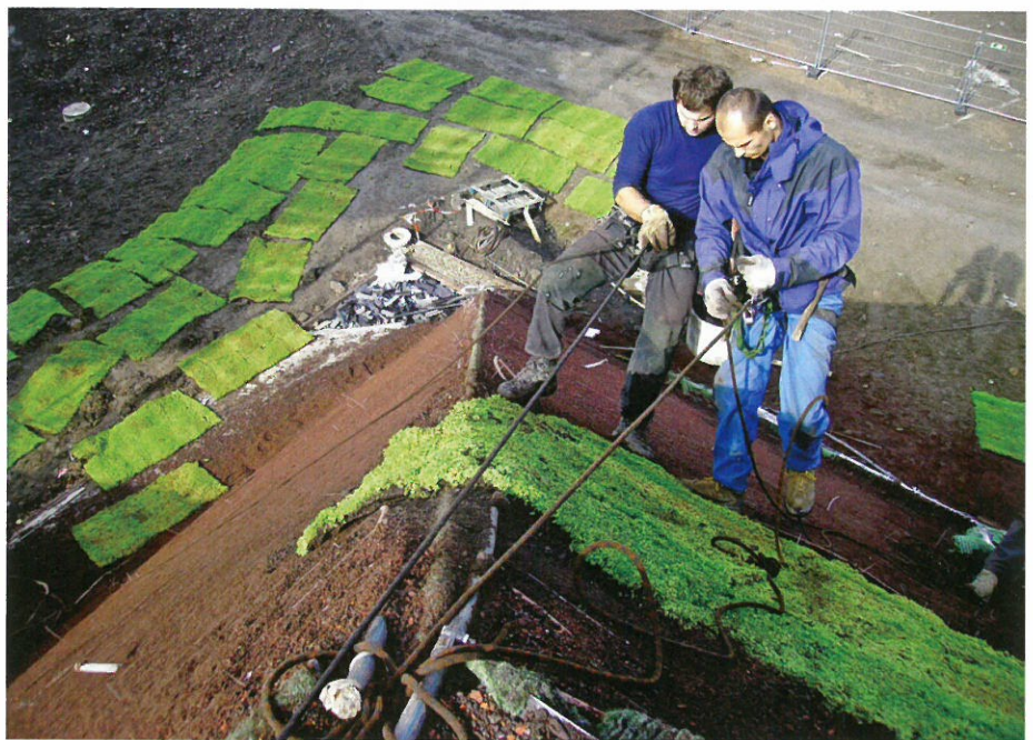
Die Begrünungsarbeiten konnten nur gut angeseilt ausgeführt werden.
